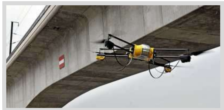
INSPECTION OUVRAGES D'ART
